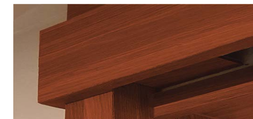
วงกบบานเลื่อนพร้อมไม้บังราง
